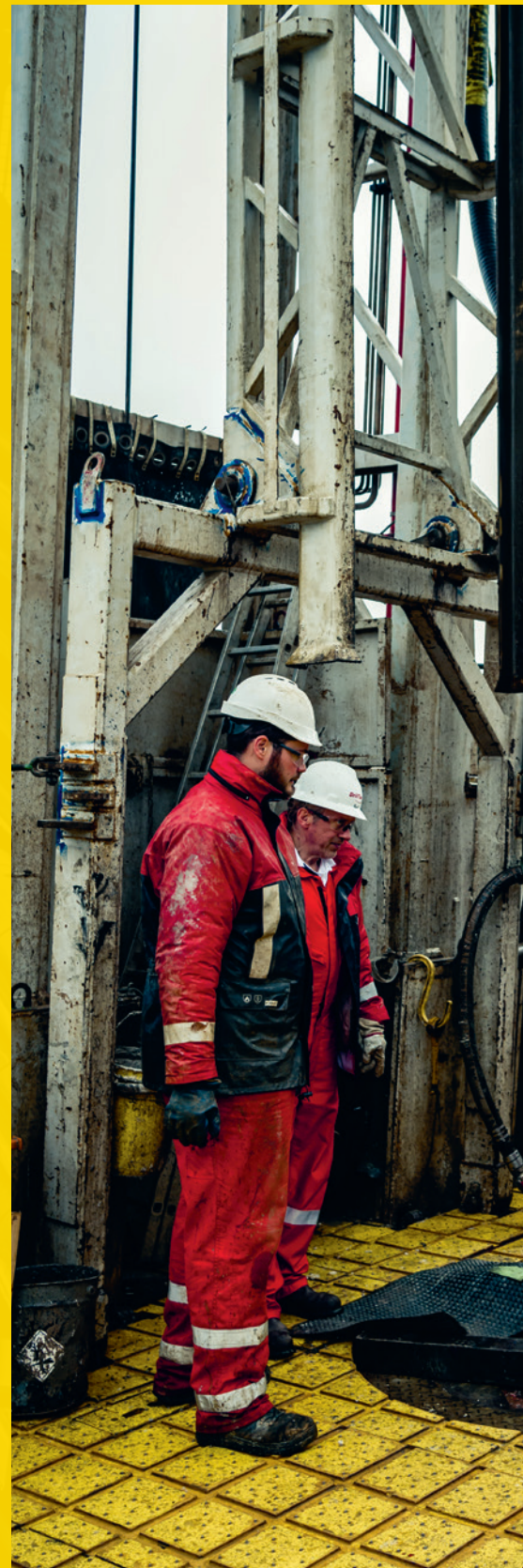
Det første geotermiske anlæg i Danmark blev opført i Thisted i 1984. Her er de ved at udvide med en ny boring i 2017. Anlægget henter varme fra 1250 meters dybde.
