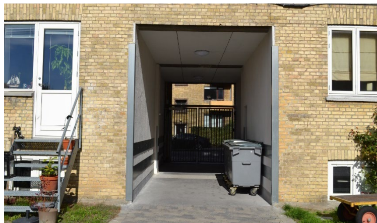
Porten ind til gården er blevet udvendigt isoleret, så de tilstødende lejligheder ikke oplever kuldeindslag. Der er monteret brede stålband langs væggene og kanterne for at skåne den nye beklædning.
