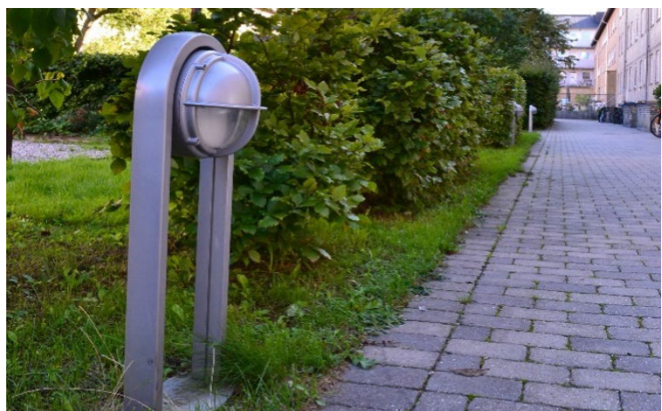
En del af de energibesparende tiltag var at få udskiftet alt udendørsbelysningen til LED.
