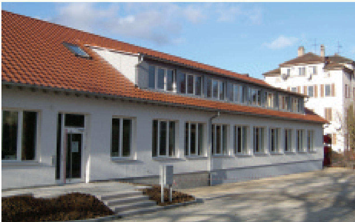
Energirenoveret kasernebygning som kontorbygning efter passivhus-standard fra Tübingen i Tyskland
