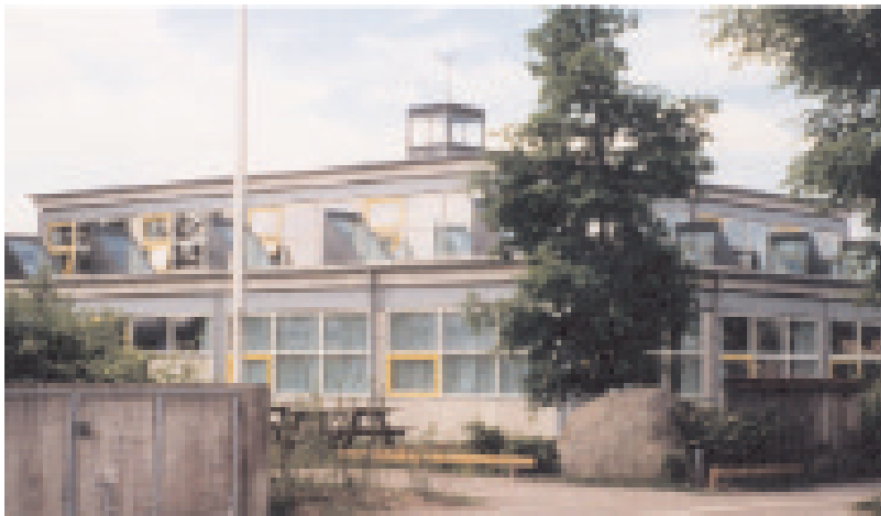
Arkitekt ved renovering: Frank Jacobsen, Ballerup Kommune, Ingeniør: Cenergia
