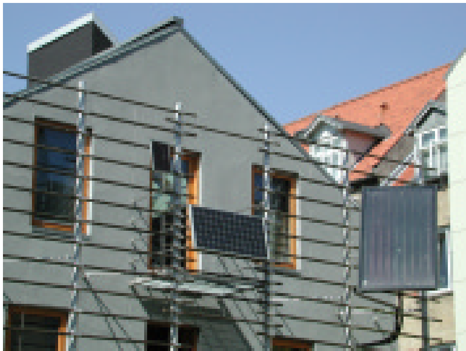
Arkitekt ved renoveringen CUBO, Ingeniør. PlanEnergi
