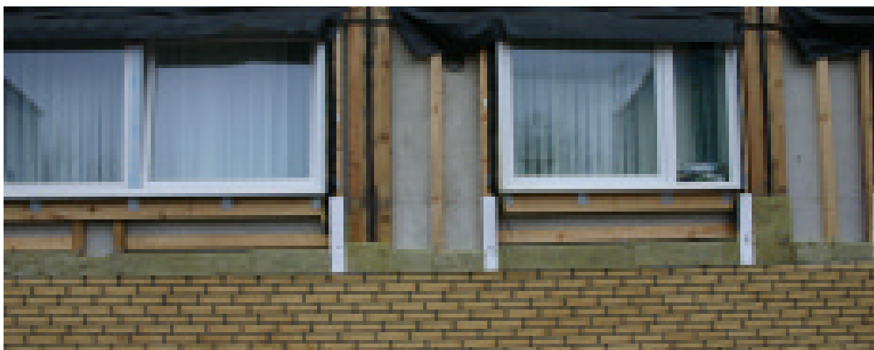
Udvendig efterisolering af Hedebo Parken i Roskilde
