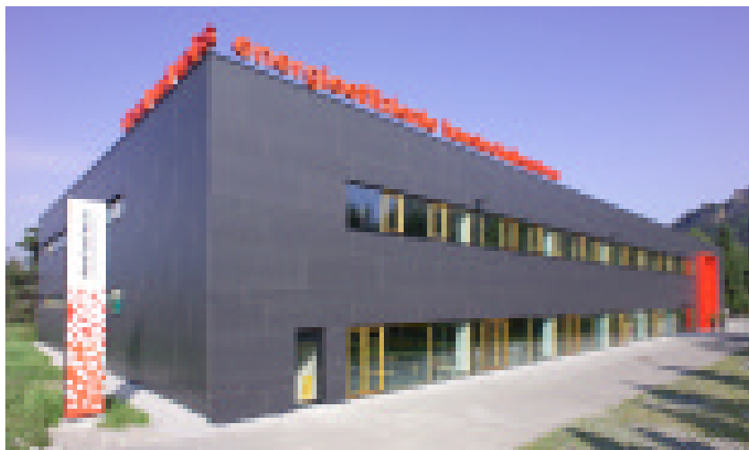
Arkitekt ved renovering: Architecturbüro Zweier, Ingeniør: Büro DI Dr. Künz, Energitechnik: Drexel und Weiss
