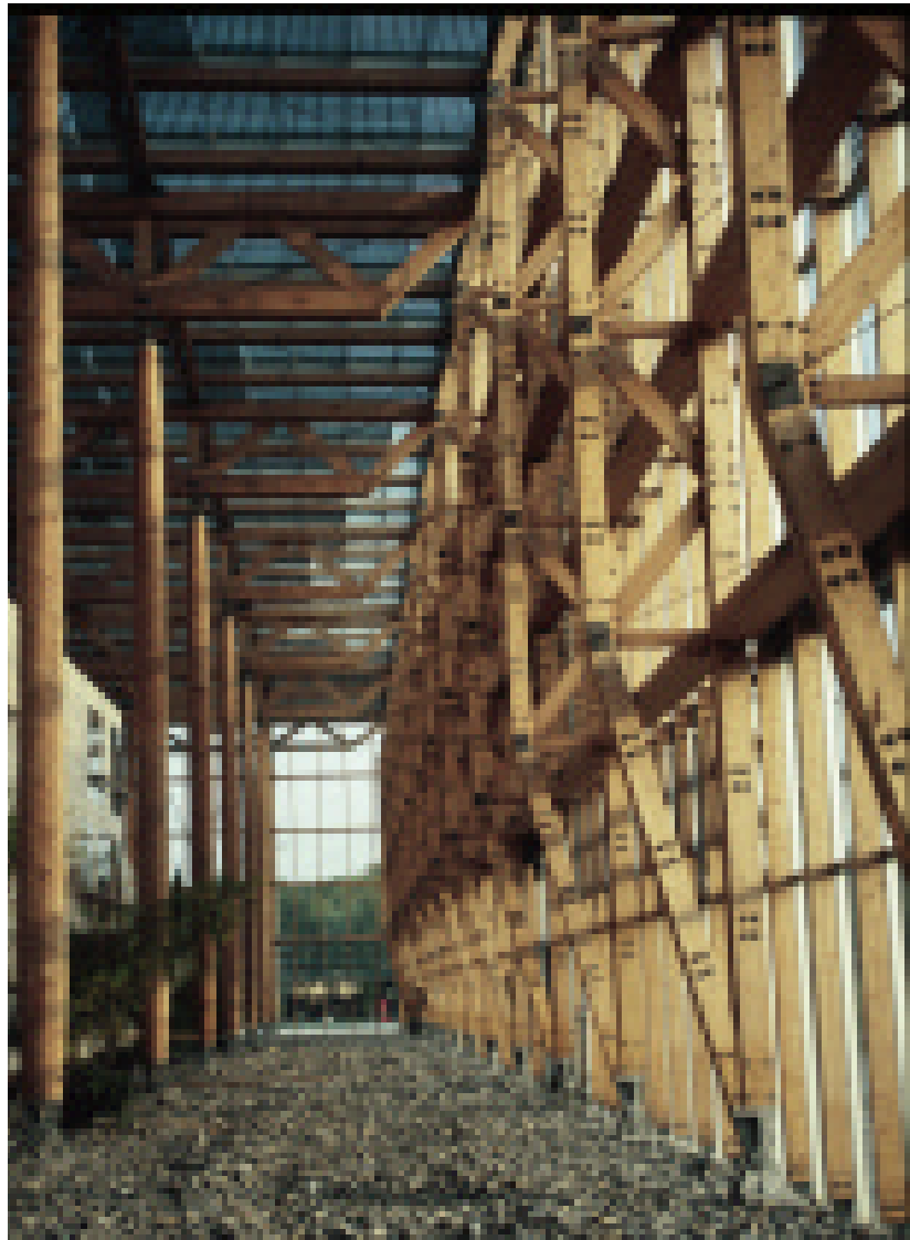
Den bærende konstruktion i medborgerhuset i Herne er opført af lokalt skovet gran - som er med til at give huset identitet. Arkitekter Jourda & Perraudin, Frankrig
