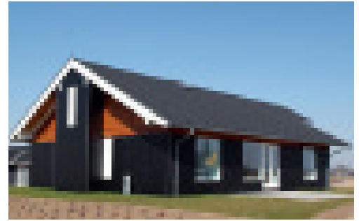
Seest Huse i samarbejde med Rockwool Lavenergi typehus 2005. Beregnet energiforbrug til opvarmning ca 25 kWh/m 2 /år. Varmeforbrug 167 kr/måned. Det målte energiforbrug til opvarmning er 26,7 kWh/år/m 2 . Arkitekt Jens Felthaus
