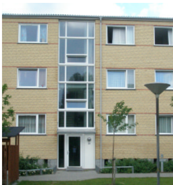
Der er behov for støttemidler så der bliver indarbejdet optimale energibesparelser i alle renoveringer i samarbejde med bl.a. Landbyggefonden. Foto er fra en omfattende renovering i Hedeboen i Roskilde.
