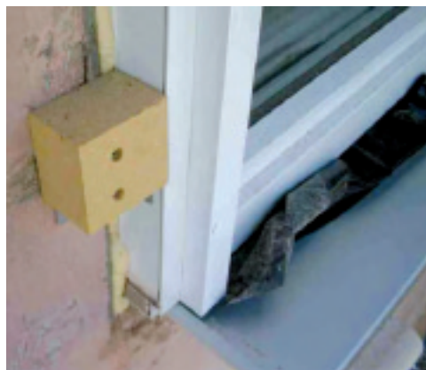
Isætning af nyt vindue med U-værdi på 0,85 med plads til udvendig facadeisolering
