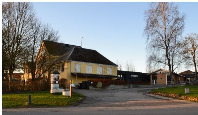
Hylke Skole og Multihus. Til venstre ses den gamle gule skolebygning. Den sorte bygning er den nye skole, der med et fælles indgangsparti forbinder Multihuset, skole og børnehave i murstensbygningen til højre.
