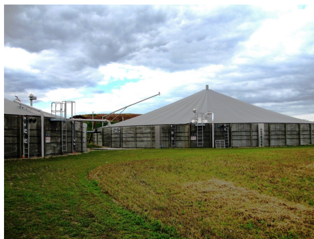
Afgasning af gylle i biogasanlæg er et effektivt virkemiddel til reduktion af metan-emissionerne fra landbruget.
