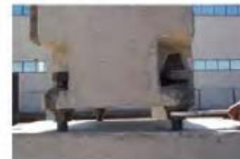
Montering og justering af elementerne kan enkelt gøres med en svenskenøgle.
