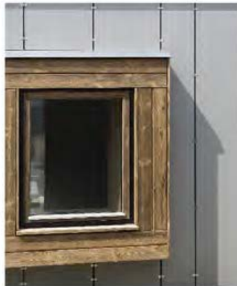
Vingebeslægene er etableret i facaden. Foto: Tobias Eskerod
