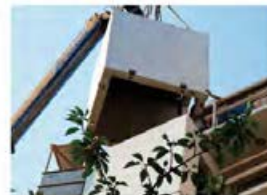
Montering af præfabrikerede betonelementer til elevatorskakt.
