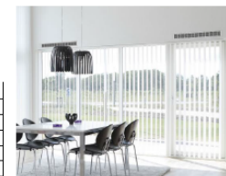
Ventilation: Microvent facadeintegreret ventilationsanlæg med varmegenvinding. To enheder i hvert rum skiftes til at udsuge og tilføre luft, hvorved varmen genvindes i en regenerator.
