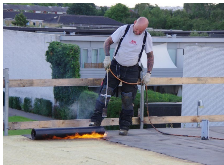
Firmaet har et hold på tre til at lægge det nye tag. En person går og lægger de faste isoleringsplader mens de to andre lægger tagpappet ovenpå isoleringen.
