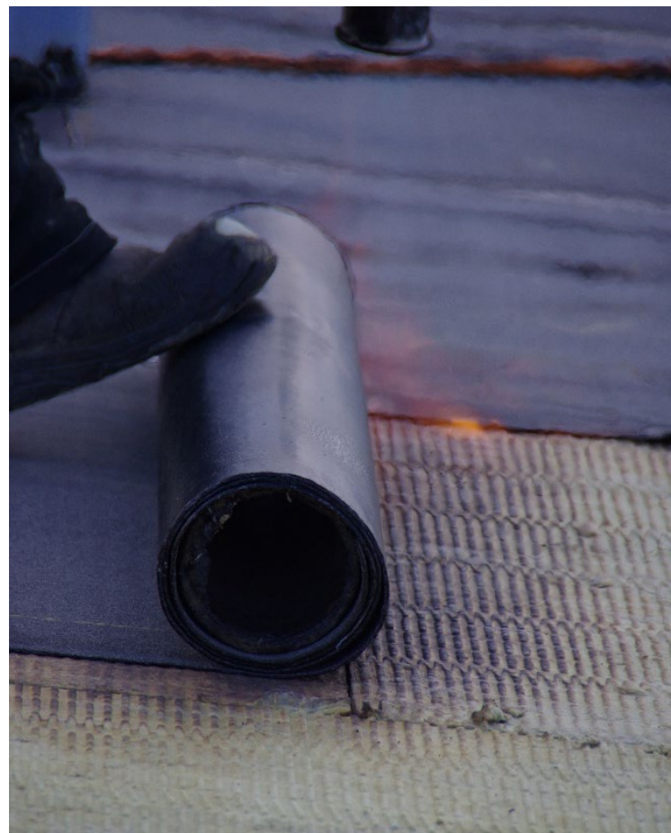
Det fælles tag fik ved renoveringen ekstra isolering og ny tagpap, som bliver lagt direkte ovenpå isoleringen.
