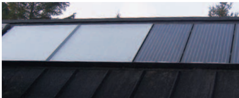
SOMMERHUSTAG MED BÅDE SOLVARME- OG SOLCELLEANLÆG FRA NORDIC ENERGY GROUP
